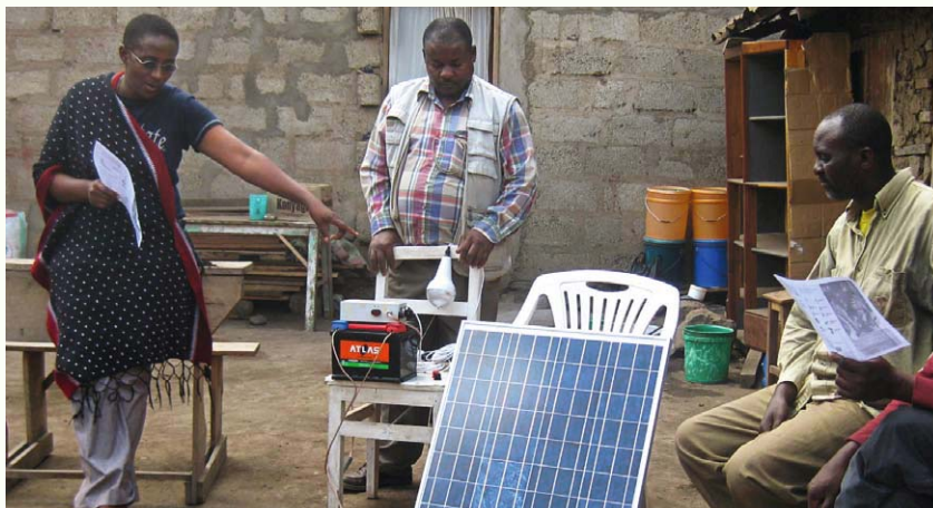
Oben: Zwei Techniker von Mobisol installieren ein Solarpanel. Unten: In einem Workshop lernen Kundinnen und Kunden von Mobisol, wie das «Solar Home System» funktioniert.
